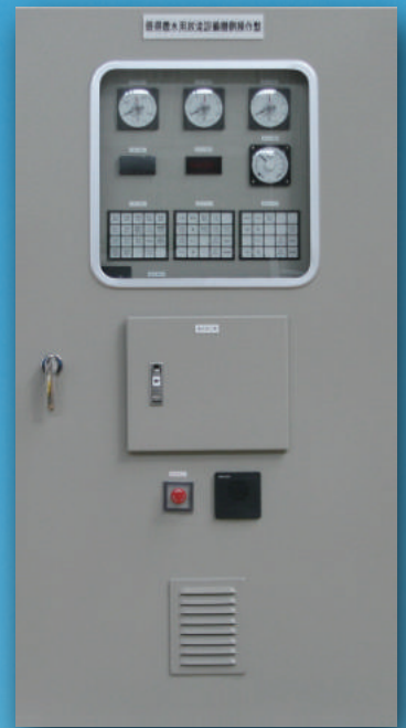
ゲート操作盤
