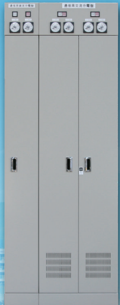
通信用分電盤
